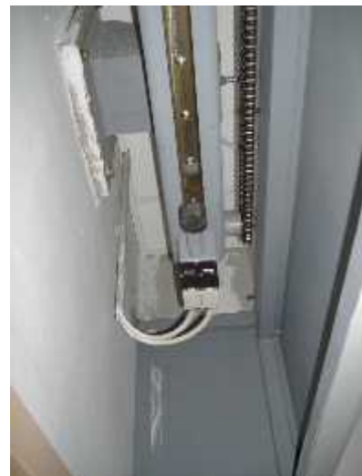
Zwangskontakt für die Gerätesteuerung (LINAC): autom. Geräteabschaltung bei Öffnen der Türe
