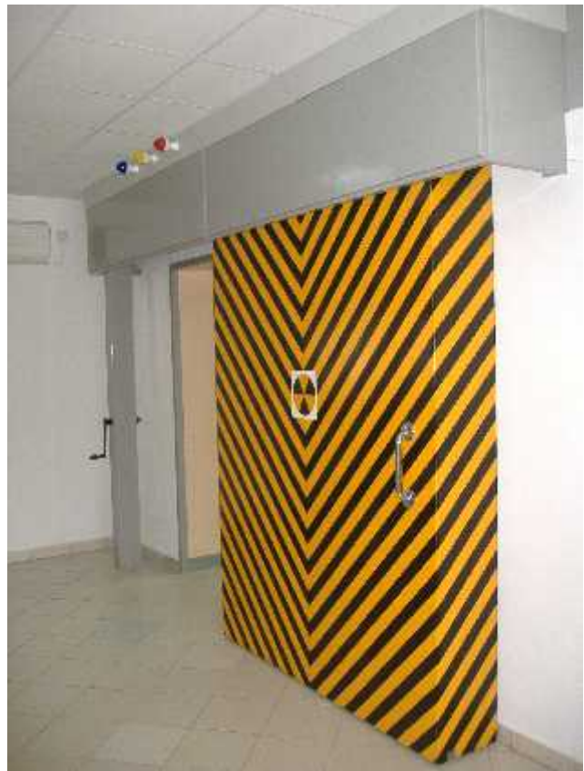
Stromunabhängige Strahlenschutz- tore mit Handkurbelbetrieb
