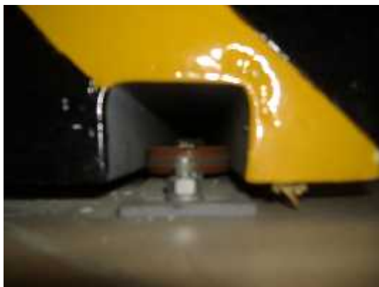
Bodenführungsrolle, im Torblatt integriert, ohne Bodenabsenkung
